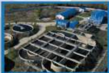
Stația de Epurare ape uzate Podoleni, Neamț
