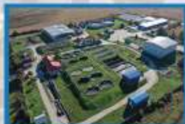
Stația de Epurare ape uzate Tîrgu Neamț
